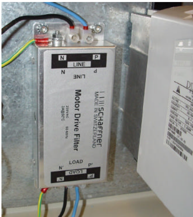
Bild 2: Beispiel eines Filters in EMV-technisch korrekter Flanschmontage
